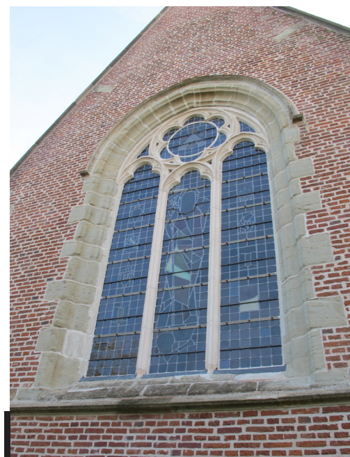
11. Van het oorspronkelijke gotische raam in het noordelijk transept zijn enkel nog de boog en de neggen origineel. Het maaswerk is het resultaat van de negentiende-eeuwse neogotische restauratie. © foto door P. Van den Hove
