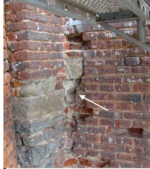
2. Detail van de zuidwestelijke hoek en de aanzet (witte pijl) van de kroonlijst van de zuidelijke gevel van de romaanse kerk. © foto door M. Cock
