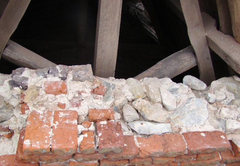
9. Een deel van het romaans en middeleeuws muurwerk van de kapel van Onze-Lieve-Vrouw gaat nog schuil in de gevel van het huidige noordelijk transept. Op de foto (buitenzijde in baksteen) is te zien hoe de binnenzijde en de kern van de muur tot in de nok nog bijna volledig is opgebouwd in veldsteen.
