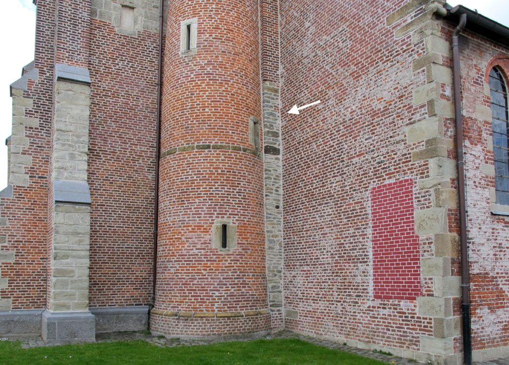
1. Tussen de traptoren en het schip van de huidige kerk is de zuidwestelijke hoek van de romaanse kerk nog bewaard, opgetrokken in veldsteen. © foto door P. Van den Hove
