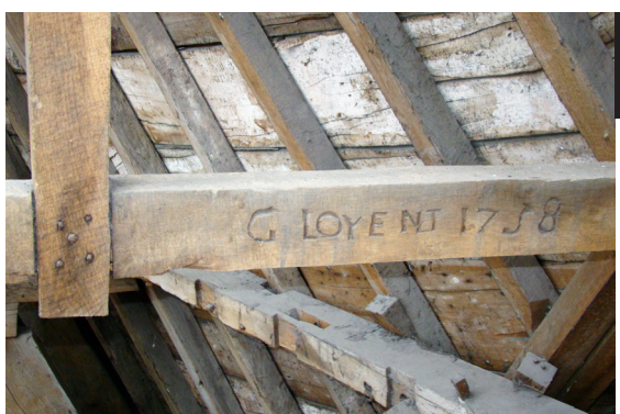
19. Timmerman Geraard Lorent laat bij de verbouwing in 1757/58 zijn naam achter op een dakbalk van het zuidelijk transept. © foto door M. Cock
