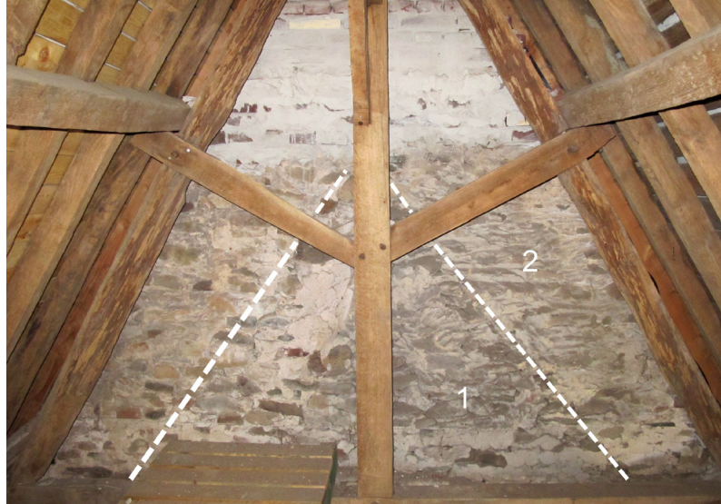
10. Onder het dak van de kapel van Onze-Lieve-Vrouw is nog de oorspronkelijke puntgevel (1) aanwezig (aangeduid in stippellijn), opgetrokken in onregelmatig gekapte veldsteen. Een latere (middeleeuwse) gotische verhoging van de daklijn (2) is eveneens in dezelfde steen uitgevoerd.
