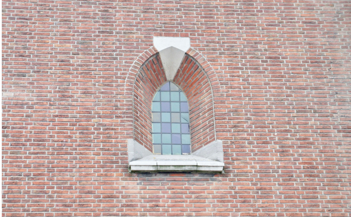
Voorbeeld van het Noors metselverband in de kerk van Erembodegem, typisch voor de invloed van de Amsterdamse School en Kropholler op de architectuur van broeder Urbain en Bressers. © foto door auteur
