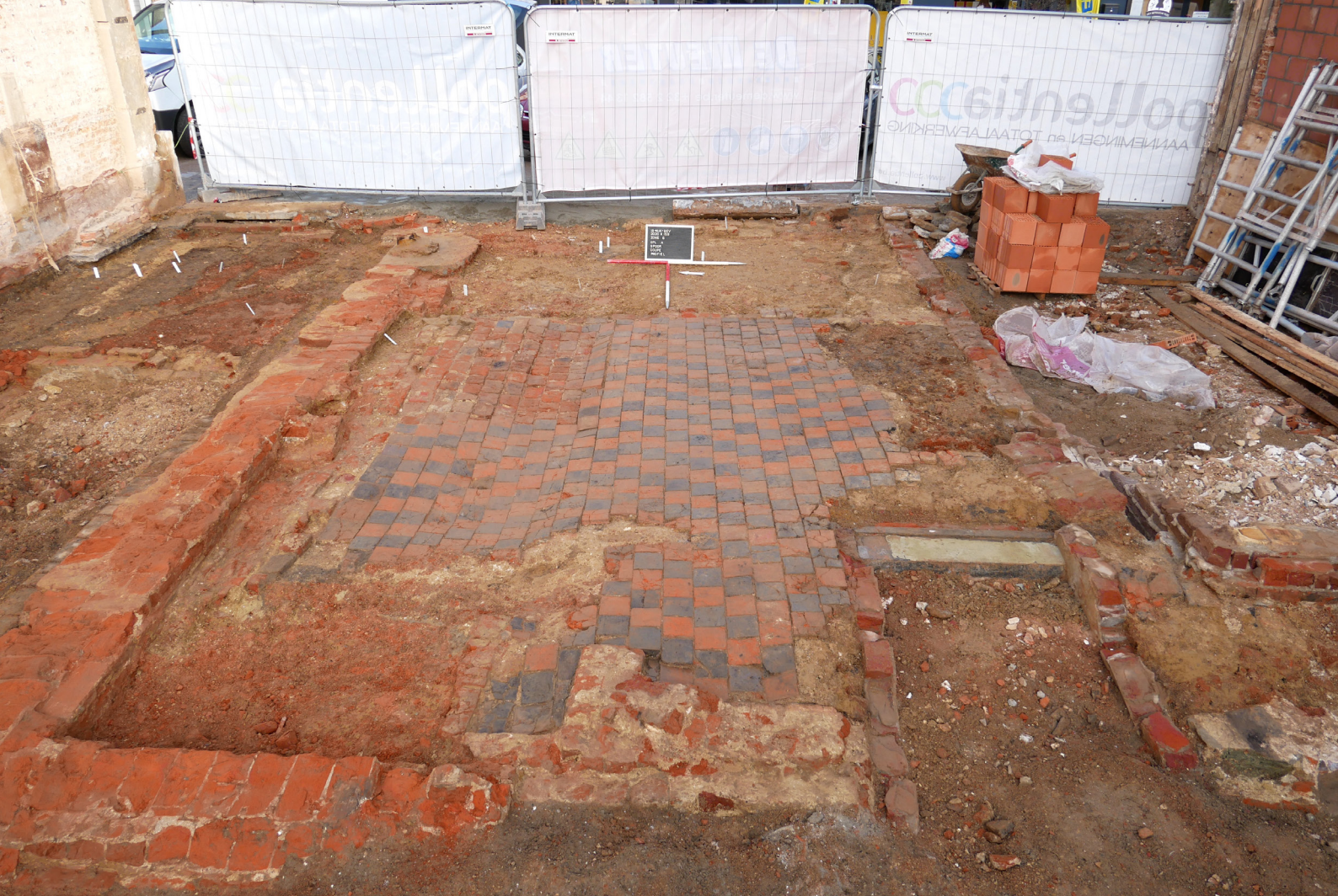
15) Zicht vanuit het zuidwesten op de tegelvloer (C. VI-42 en C. VI-43) op GPLA.
