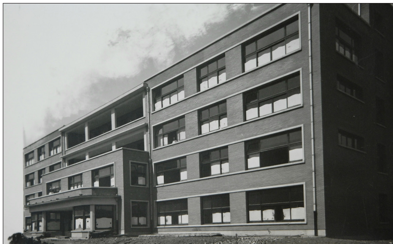
Foto van de zuidgevel (hoofdgevel) van het rusthuis direct na de afwerking in 1939, gerealiseerd door de firma Jan De Nul uit Aalst. Het toen nog rechtstaande oude gebouw is op de foto weggewist. Bron: ©Bedrijfsarchief Jan De Nul.
