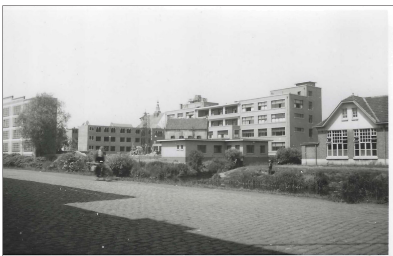
Foto gemaakt circa 1942 met een algemeen gezicht op het rusthuis en het in aanbouw zijnde ziekenhuis.
