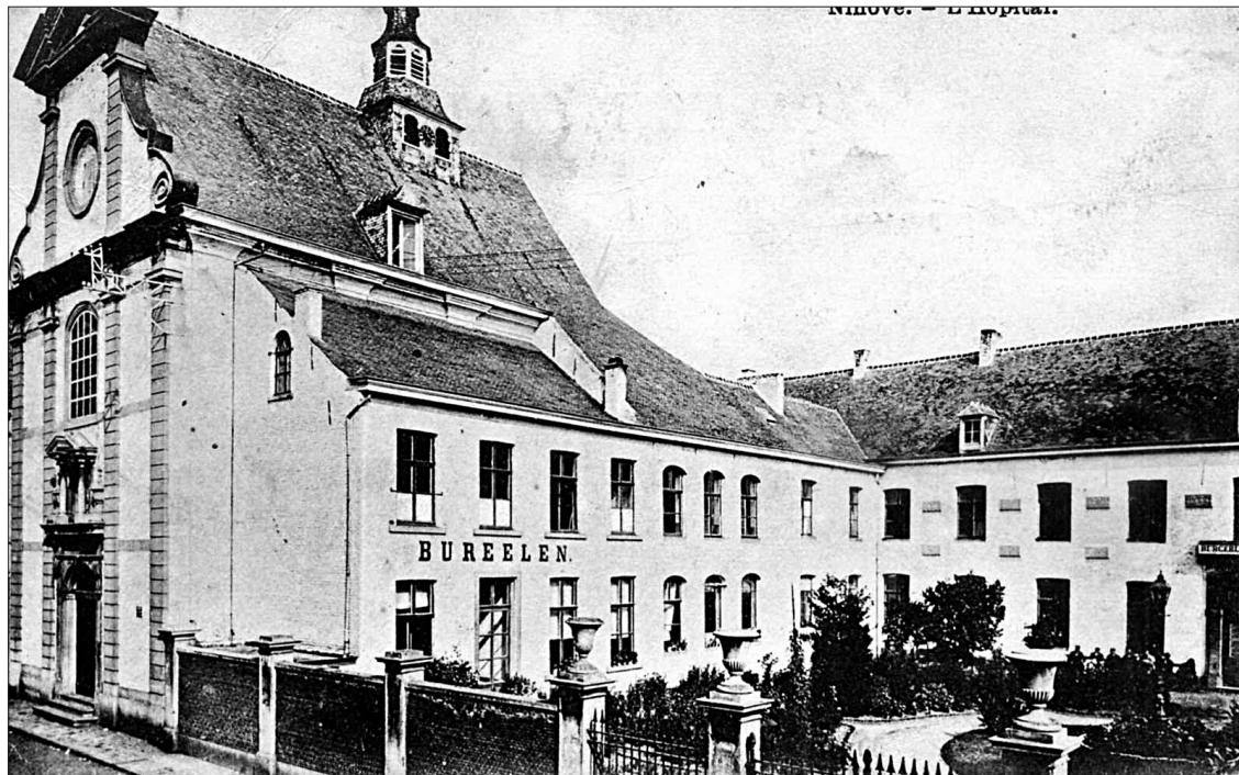
De 'Bureelen' aangebouwd tegen de kapel ca. 1877.
